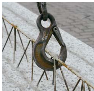
Obr. 5: Hák žeriava v uzlových bodoch priehradového nosníka
