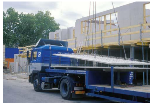
Obr. 14: Vykladanie stropných dosiek
