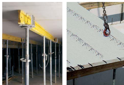
Obr 3 a 4: Montážne podstojkovanie
