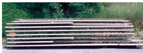
Obr. 7: Skladovanie stropných dosiek
