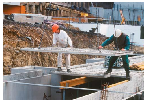
Obr. 15: Kladenie stropných dosiek
