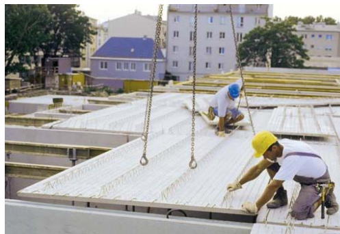
Obr. 8: Uloženie stropných dosiek
