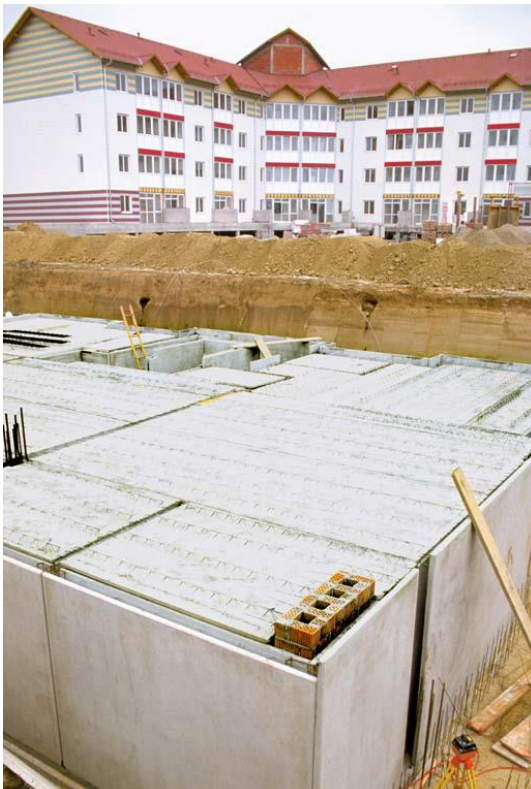
Obr. 17: Filigránový strop na veľkometrážnej pivnici
