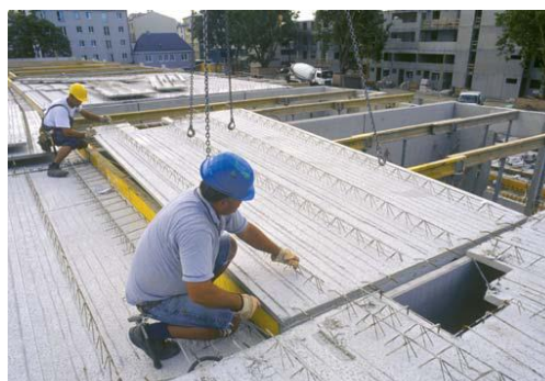
Obr. 9: Minimálne uloženie dosiek: odporúčaná dĺžka uloženie je 5 cm, inak treba dosky na okrajoch podstojkovať
