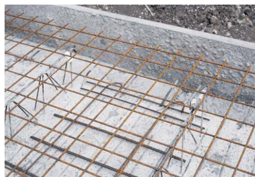
Obr. 10: Horná výstuž a stykacia výstuž
