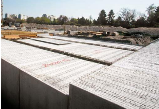
Obr. 16: Uložený filigránový strop
